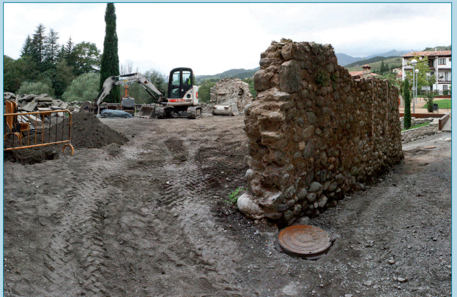
El parc, just a l'inici de les obres
