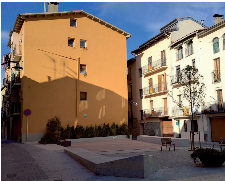
Enderroc d'un edifici a la plaça Comamala i ampliació de l'espai públic
