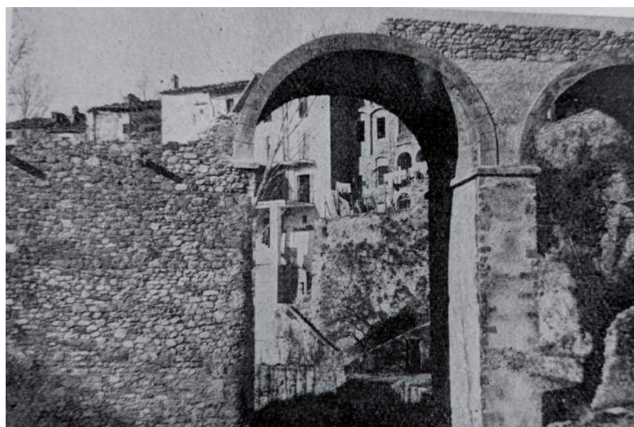
Reconstrucció del pont sobre el riu Arçamala.
