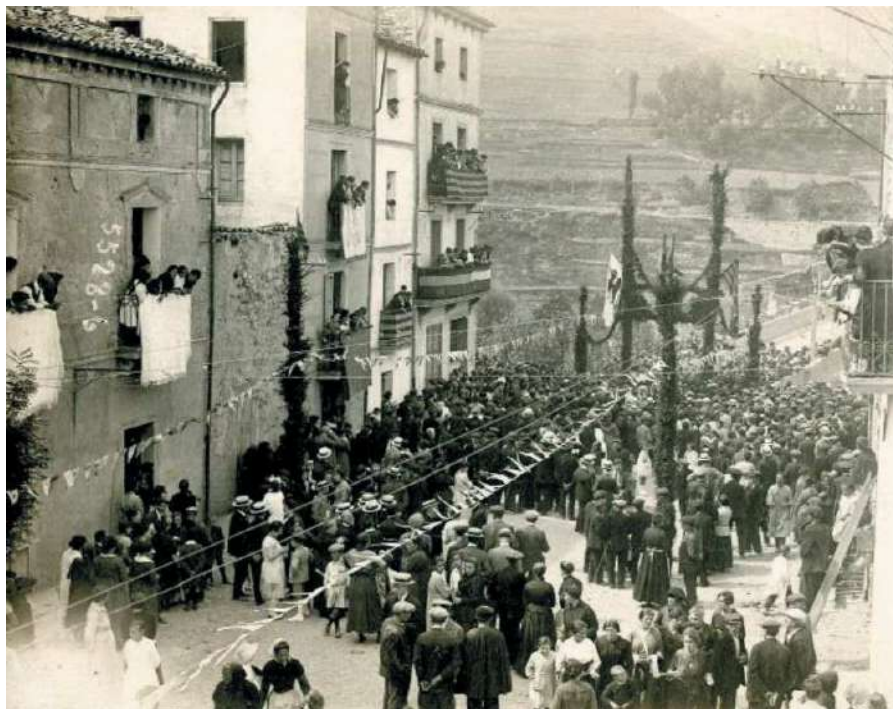
Figura 8. Concentració de vilatans en un dels extrems del pont Nou de Sant Joan de les Abadesses, tot esperant l'arribada de les autoritats que l'han inaugurat. 5 de setembre de 1920. AMSJA. Autor: Mauri. Col·lecció fotogràfica de la família Roqué (detall)
