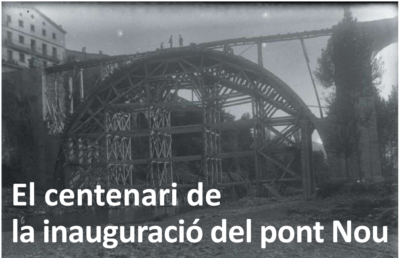
Figura 4. A finals del mes de juliol de 1919 s'enllesteix l'estructura de fusta preparatòria per a la construcció de l'arc de formigó armat del pont Nou de Sant Joan de les Abadesses. ANC. Brangulí (fotògrafs), 33507
