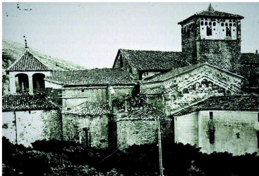
El monestir en plena restauració de Puig i Cadafalch. Ja s'havien rebaixat les defenses que hi havia sobre els absis, però encara quedava feina per fer.
